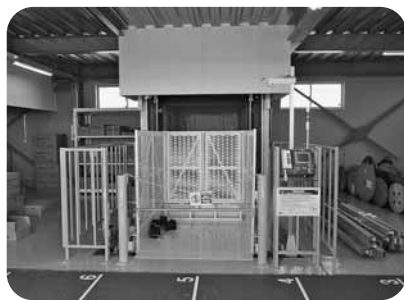
【オートレーター】 垂直搬送機を新設しました。（既存テーブルリフト廃止撤去）
