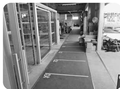
【倉庫増設部内部（1F）】
