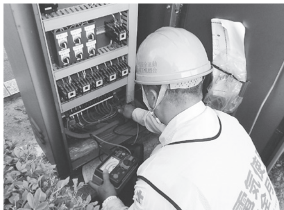
分電盤の点検
