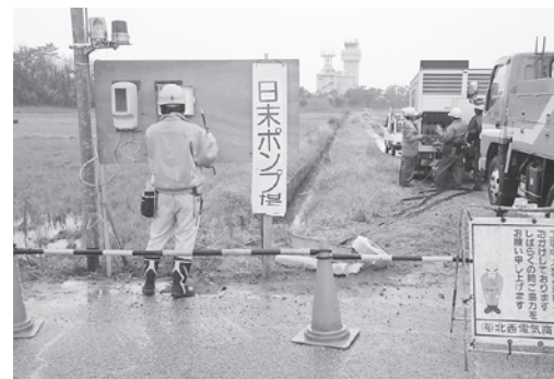
ポンプ場の仮復旧作業
