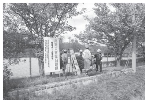
病院への復旧送電作業
